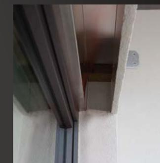
↳ Podžbukna maska pripremljena za montažu žaluzine s elektropogonom
